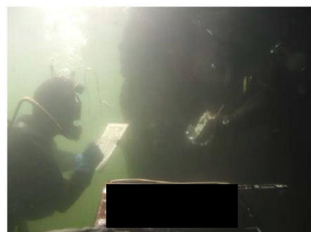
写真 3.3 潜水目視状況
