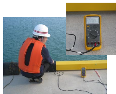
写真 3.2 電位測定状況
